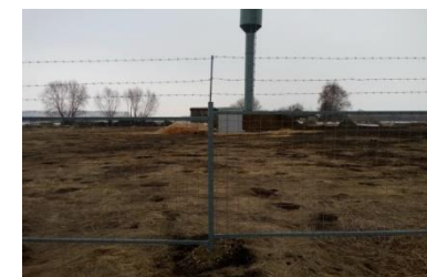
Строительство сетей водоснабжения с. Куриловка Усманского района
