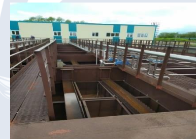
Строительство сетей водоотведения и очистных сооружений в селе Долгоруково Липецкой области
